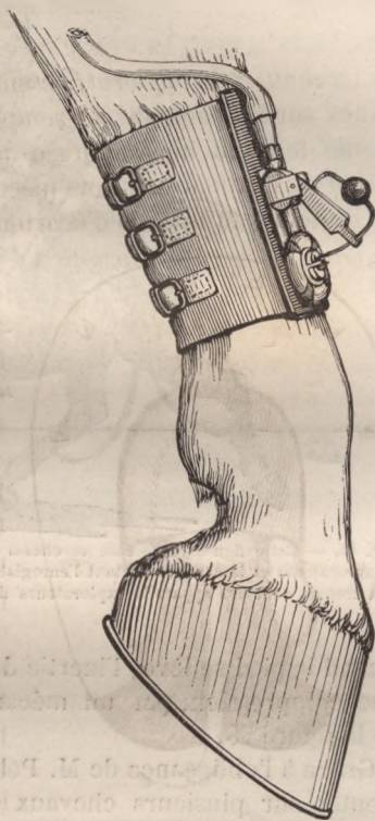
Fig. 43. — Appareil destiné à signaler les appuis et levés du sabot du cheval.
