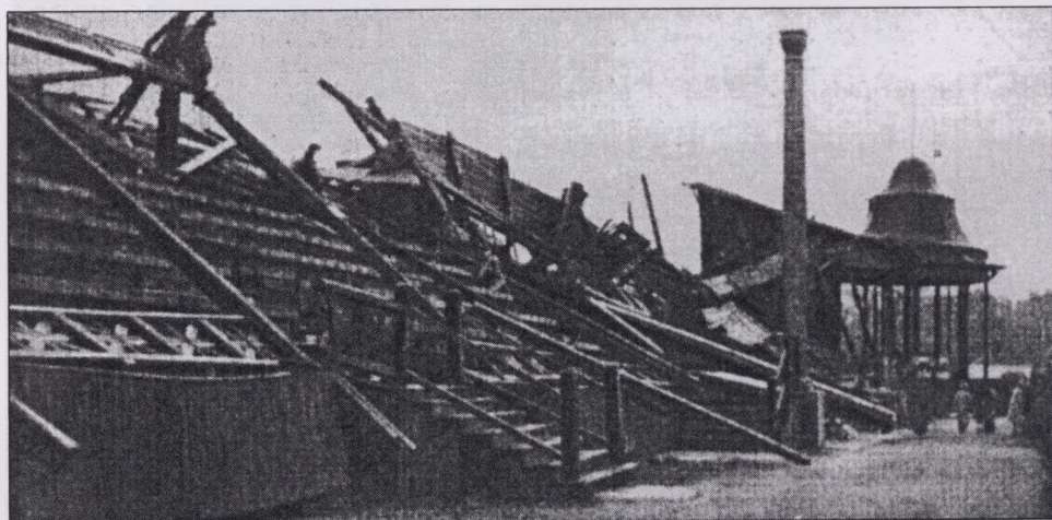
Fot. 16. 1935 r. Widok zniszczonej przez wicheru trybuny na stadionie krakowskiej „Wisły” (zdjęcie z 1935 r.)
