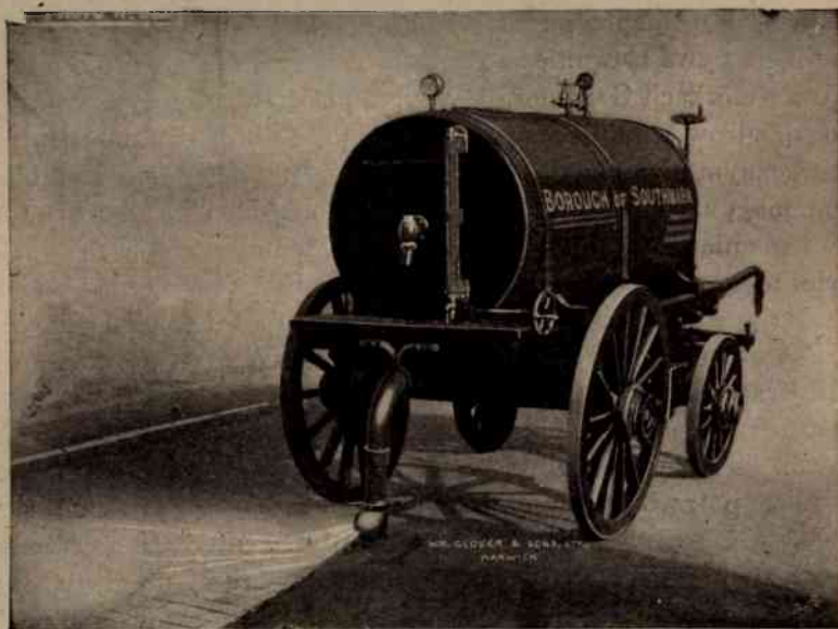
Rys. 140. Przyrząd do polewania ulic syst. Glovera (Warwick).
