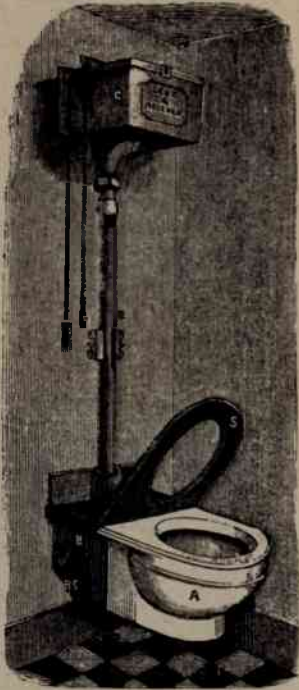
Rys. 116. Kłozet syst. Hellyer'a.
