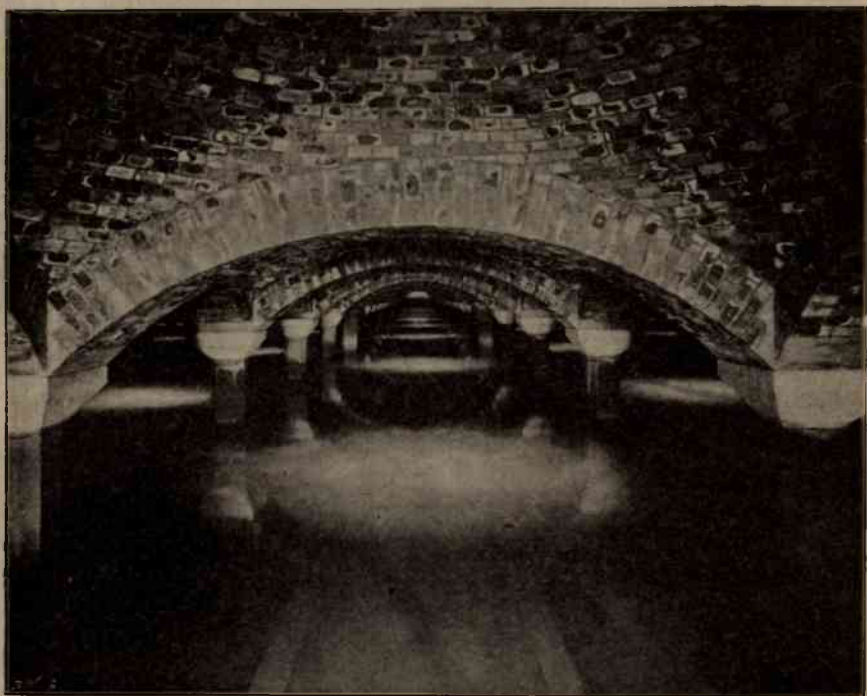
Rys. 39. Wodociąg warszawski. Widok filtru napelnionego wodą.
