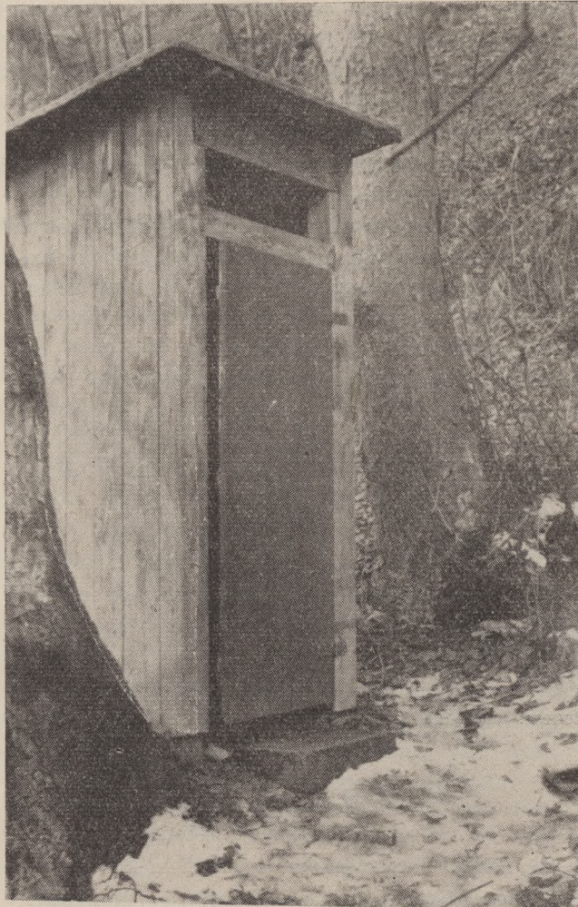
Ryc. 2. Ustęp wolno stojący Fig. 2. Toilet — outside the building
