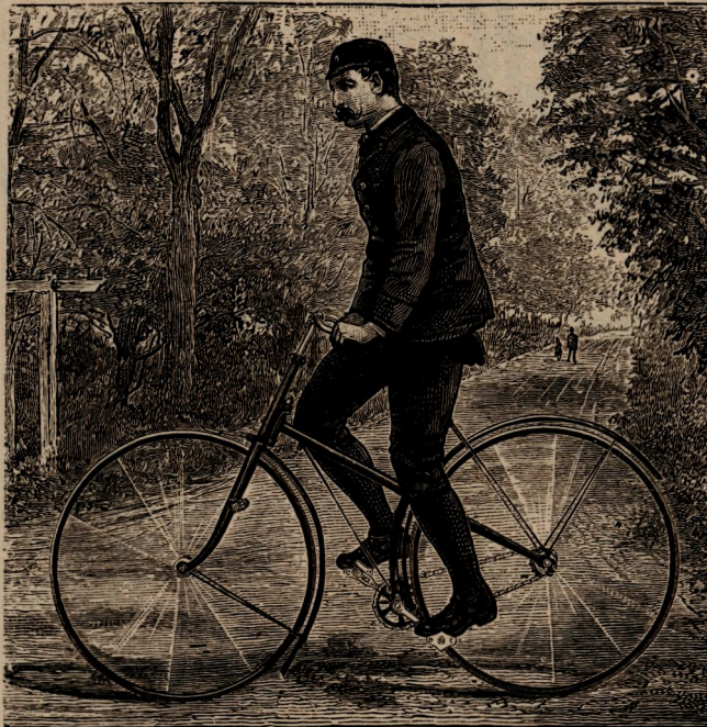
Kreuzrahmenrover mit Stahldrahtverspreizung und Vollreifen, circa 1887, System «Adlers».
