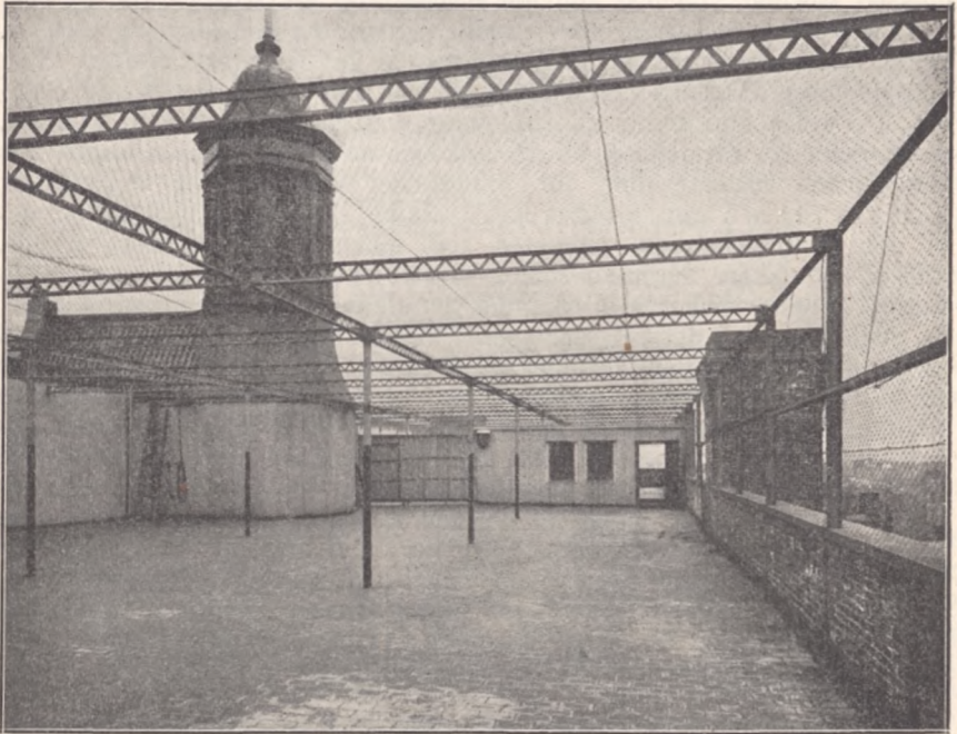
Fig. 20. Ein Stück des Dachspielplatzes einer Volksschule in New-York. Nach Snyder.
