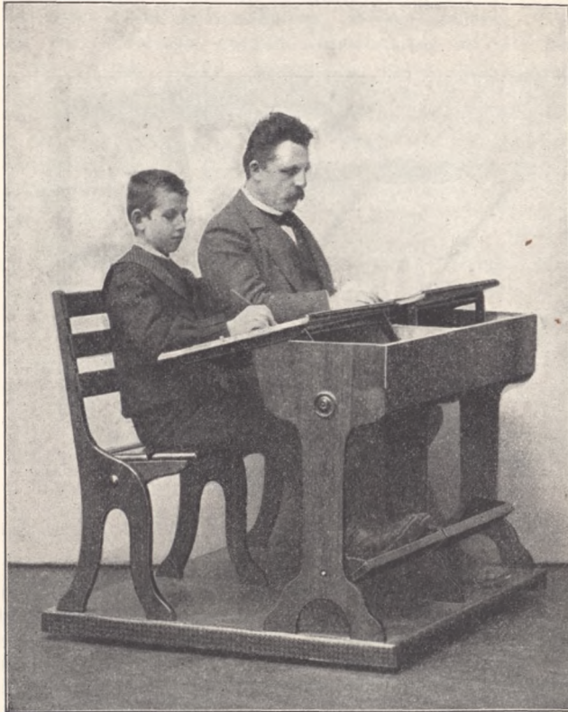
Fig. 160. Älteres Modell von Schenk's „Simplex“. (Im Bilde Dr. Schenk selbst und sein Sohn.) Die Fußbrettkonstruktion findet sich auch beim neuen Modell II von „Simplex“.
