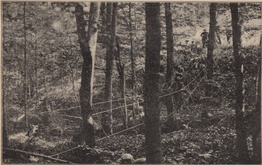
Most linowy z trzech lin, zrobiony przez patrolę instruktorów kursu scoutowego przy »Sokole-Macierzy«.
